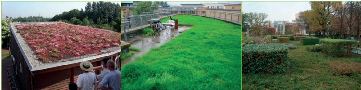
Toiture extensive et semi-intensive – Source : Agence de l'Énergie Val-de-Marne Vitry
